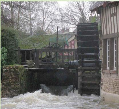
**Un moulin à eau** est une installation destinée à utiliser l'énergie mécanique d'un cours d'eau dont une partie du courant est déviée vers le moulin par un canal artificiel appelé bief.
